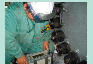
適切で均一に締め付けるため、超音波法によるボルト締結管理を採用
