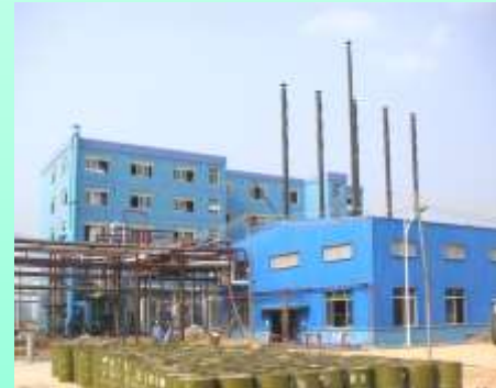
ロジン精製プラント外観
