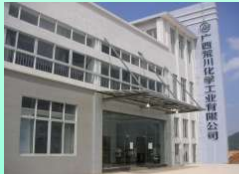
事務所棟外観
